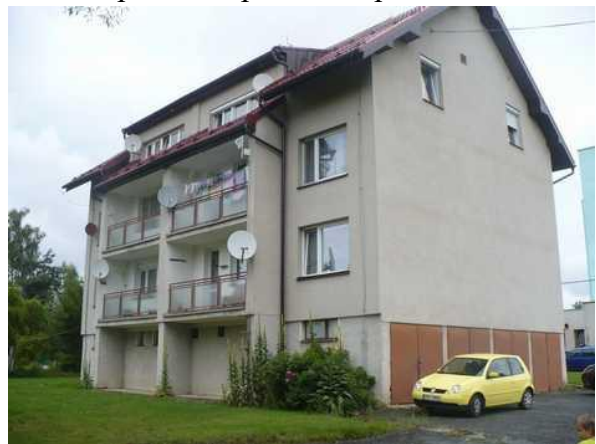
uliční pohled na bytový dům
