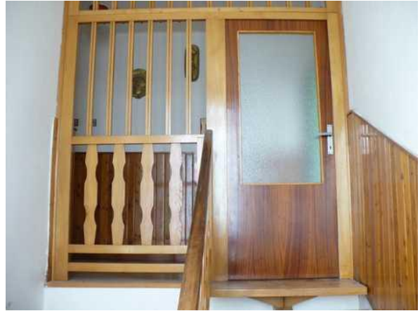
schodiště a vstup do II.NP
