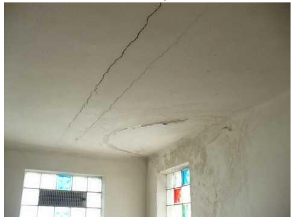
poškozená část stropu po zatékání
